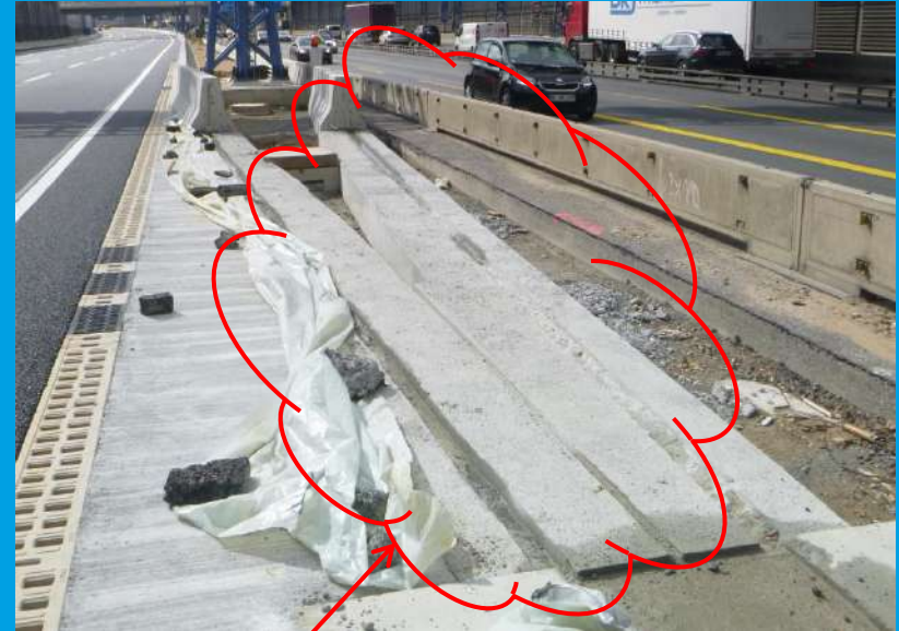
Übergang von doppelseitigem MÜLS auf 2 einseitige BSWF als Y-Stück
