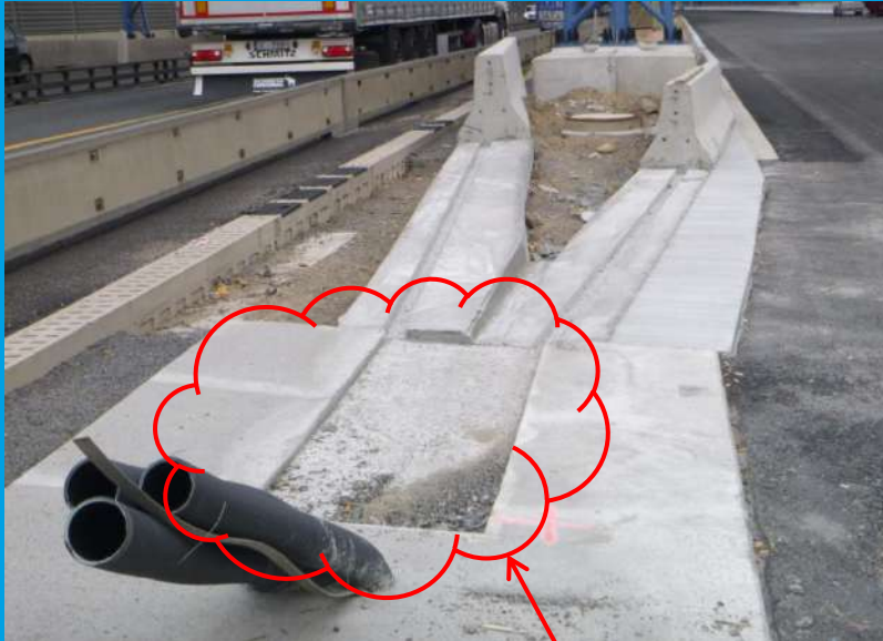
Aussparung Anschlussstück BSWF (eingespannt) auf gemeinsamem Fundament
