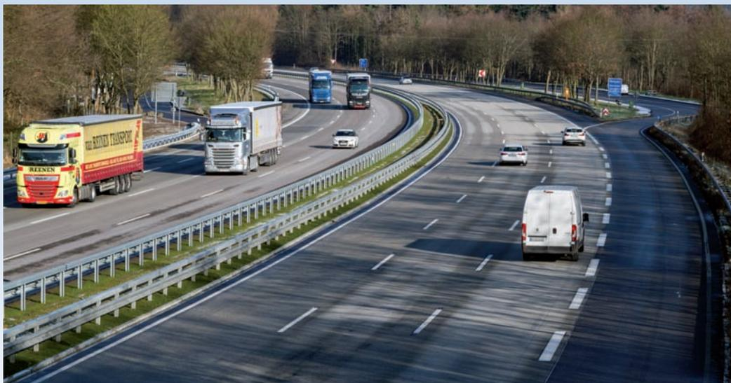
Bild 3: Super-Rail Eco zweifach, H2-W4-A
