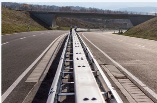
Bild 4: Super-Rail Eco doppelt, H2-W4-B
