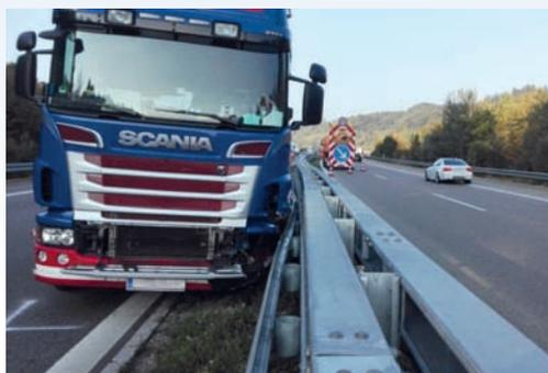
Bild 5: Super-Rail doppelt, H4b-W5-B
