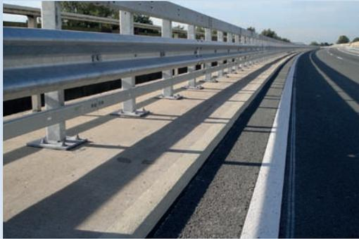
Bild 6: Super-Rail Plus Bauwerk, H4b-W6-B
