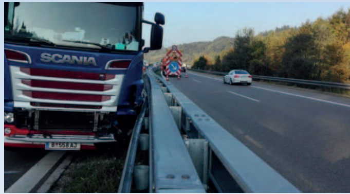
Bild 6: Super-Rail doppelt (H4b/L4b-W5-B)
