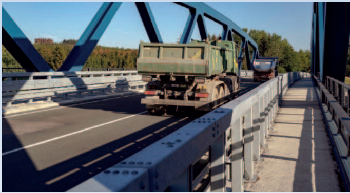
Bild 5: Super-Rail Pro BW (H4b/L4b-W2-B)
