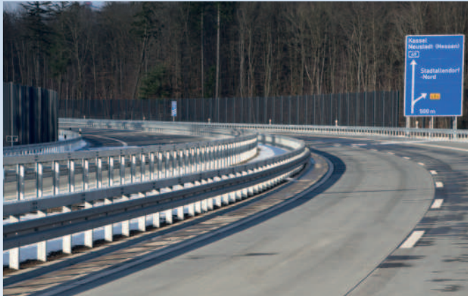
Bild 3: Super-Rail Eco zweifach (H2/L2-W4-A)
