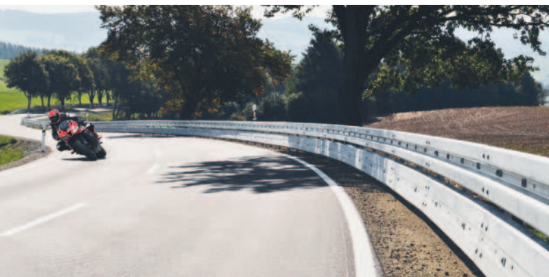
Bild 2: Unterfahrschutz für Zweiradfahrer Eco-Safe MPS (H1/L1-W4-A)
