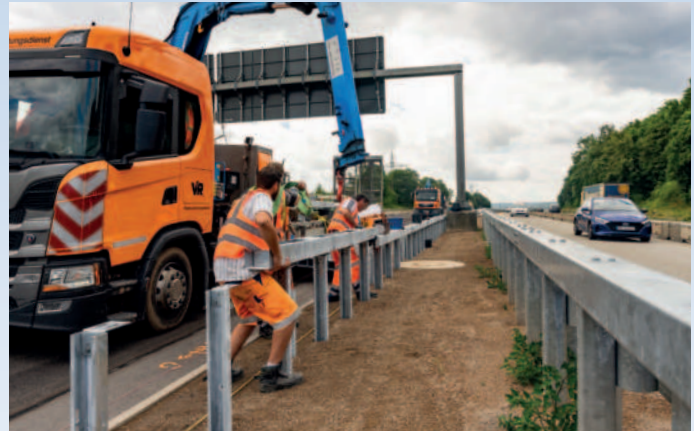
Bild 4: Super-Rail Eco HS (H2/L2-W2-B und H4b/L4b-W4-B)
