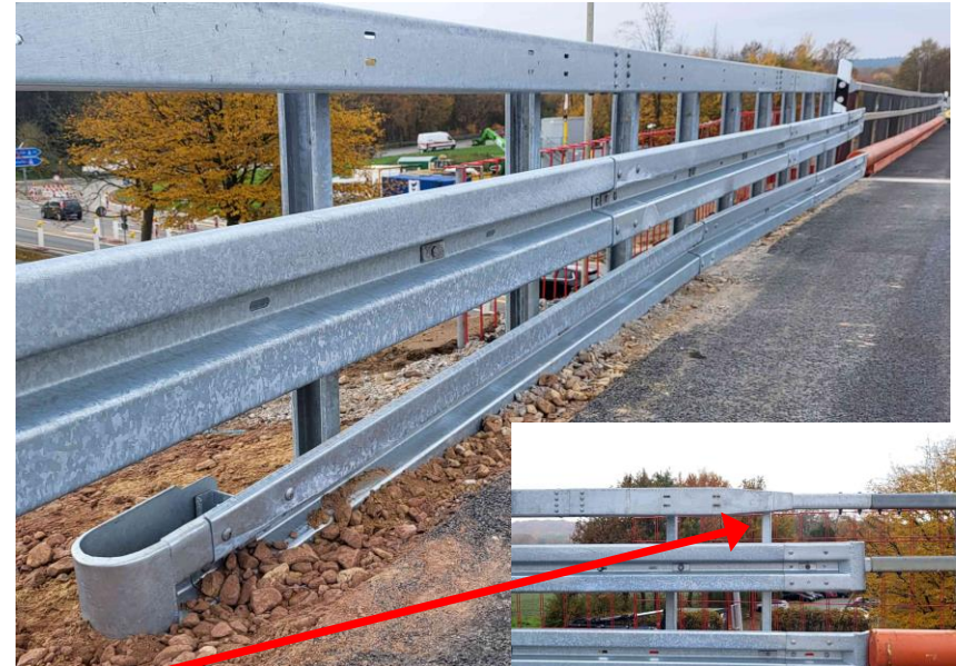
Holm-Übergang Super-Rail auf unteres BN4-Profil
