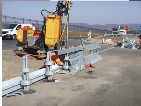
Montage ÜK Vario Connect auf SR Eco
