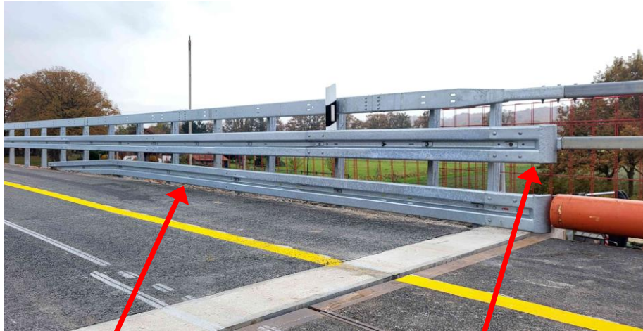
Holm-Übergang Super-Rail auf unteres BN4-Profil
