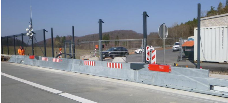
Ansicht Duo Gate Double und Verankerung auf Fundament
