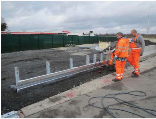
4.15 Montage des oberen Holmes nach dem unteren Holm Mounting the upper guardrail- beam after the lower beam
