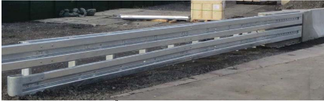
4.20 Vorderseite des fertigen Übergangs BeStCONNECT-EcoSafe Front side of finished transition BeStCONNECT-EcoSafe
