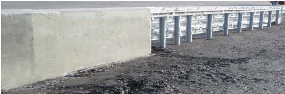
4.21 Rückseite des fertigen Übergangs BeStCONNECT-EcoSafe Back side of finished transition BeStCONNECT-EcoSafe
