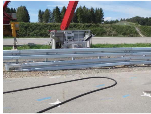
4.16 Der untere Holm wird nach 4 m abgesenkt Dropping down the lower beam after 4 m
