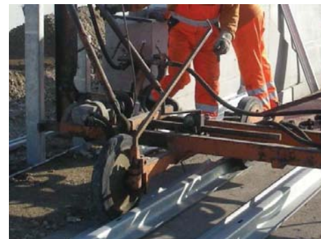
4.10 Die Holme können als Schiene für die Ramme benutzt werden Beams can be used as guide rail for the piling frame
