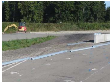
4.8 Auslegen der Stahlteile Laying the steel parts
