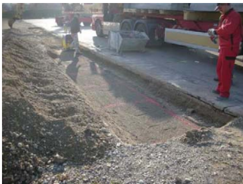
4.3 Herstellen des Splittbettes Leveling layer of grit
