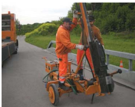
4.11 Aufbauen und lotrechtes ausrichten der Ramme Preparing and adjusting the pile driver vertically
