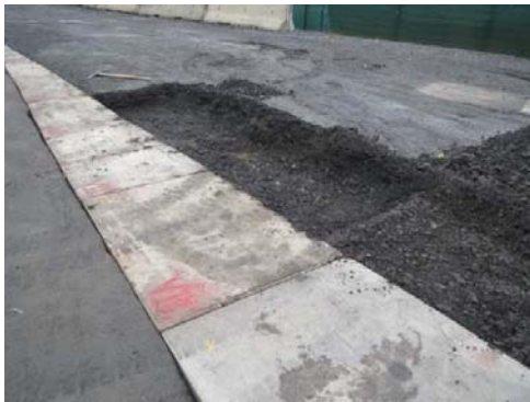
4.1 Auskoffern des Untergrundes Excavated soil
