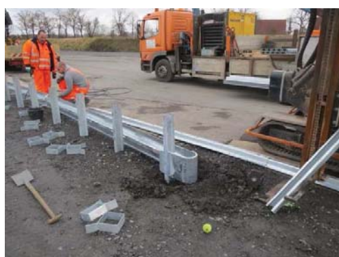
4.14 Montage erfolgt Zug um Zug mit dem Rammen der Pfosten Mounting follows step by step the piling frame
