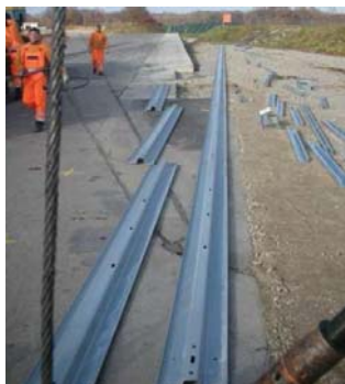
4.9 Ausrichten der Holme Aligning the beams
