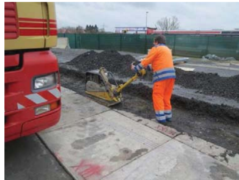
4.2 Verdichten des Untergrundes Compacting ground
