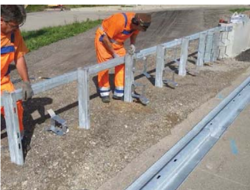
4.13 Anhängen und vorverschrauben der Bauteile Fixation of the steel components
