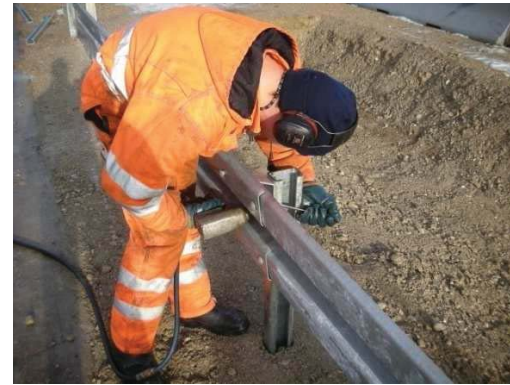
4.18 Festziehen der Schrauben... Tightening the screws...
