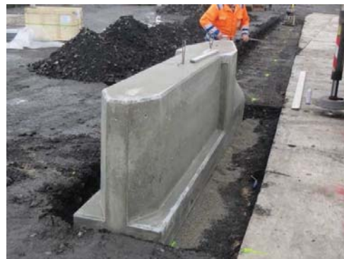
4.4 Aufstellen d. Anschlußelementes Setting up connection element
