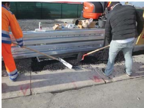
4.7 Verfüllung Arbeitsraum / Asphalt Backfilling excavation / asphalt
