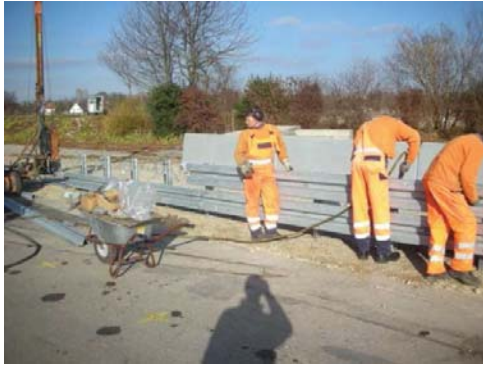
4.16 Montage des oberen Holmes nach dem unteren Holm Mounting the upper guardrail- beam after the lower beam
