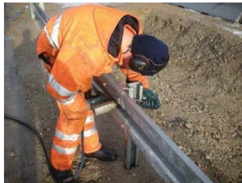
4.21 Festziehen der Schrauben... Tightening the screws...
