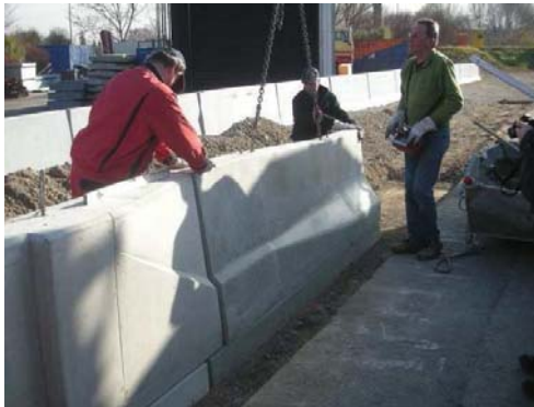
4.5 Versetzen des Zwischenelementes Positioning adaptor element
