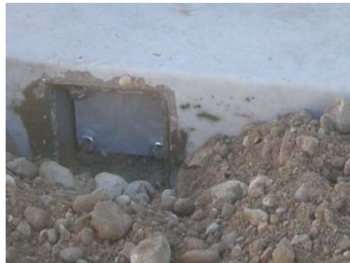
4.7 Einsetzen und verschrauben des Dampfungselementes Inserting and fixing the deformation-element
