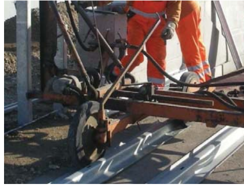
4.11 Die Holme werden später als Schiene für die Ramme benutzt Using the beams as guide rail for the piling frame
