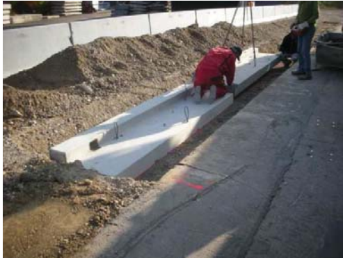
4.3 Versetzen der Fundamentplatten Positioning foundation plates
