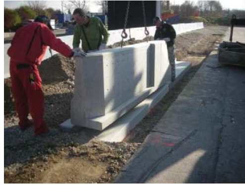
4.4 Aufstellen d. Anschluelementes Setting up connection element
