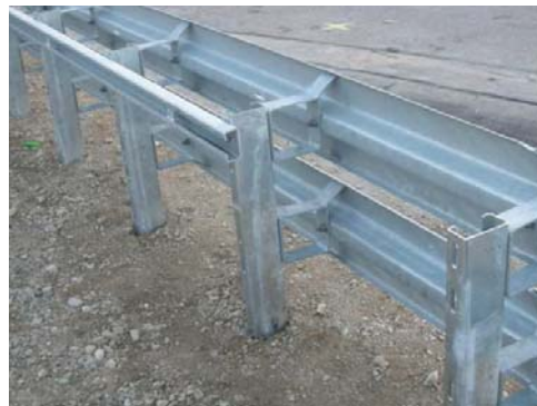
4.19 Ende der C-100 Gurtabspannung End of the C-100 tensioning
