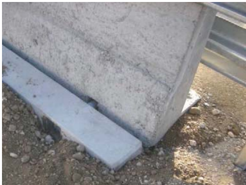
4.7 Einsetzen und verschrauben des Dampfungselementes Inserting and fixing the deformation-element
