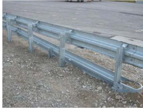
4.17 Der untere Holm wird nach 8m abgesenkt Dropping down the lower beam after 8m
