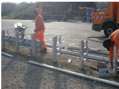
4.14 Anhängen und vorverschrauben der Bauteile Fixation of the steel components
