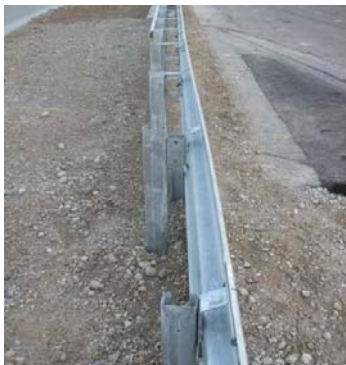
4.20 Verschwenkung der Pfosten am Ende des Übergangs Distortion of the posts at the end of the transition
