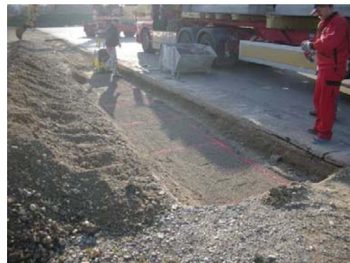
4.2 Herstellen des Splittbettes Leveling layer of grit
