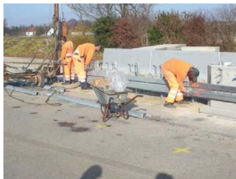
4.15 Montage erfolgt Zug um Zug mit dem Rammen der Pfosten Mounting follows step by step the piling frame
