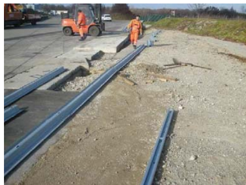
4.9 Auslegen der Stahlteile Laying the steel parts
