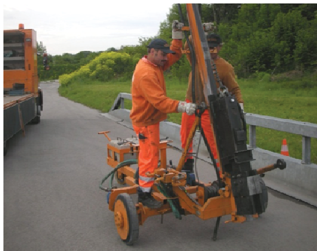
4.12 Aufbauen und lotrechtes ausrichten der Ramme Preparing and adjusting the pile driver vertically
