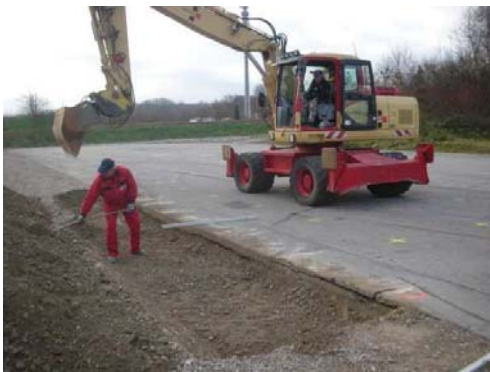
4.1 Auskoffern des Untergrundes Excavated soil
