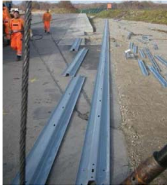
4.10 Ausrichten der Holme Aligning the beams
