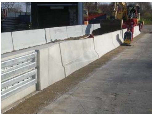
4.8 Verfüllen des Arbeitsraumes Backfilling the excavation
