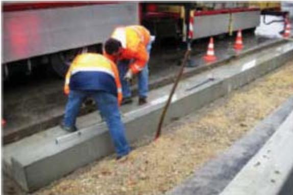
Fertigteilfundamente auf Planum setzen und ausrichten
