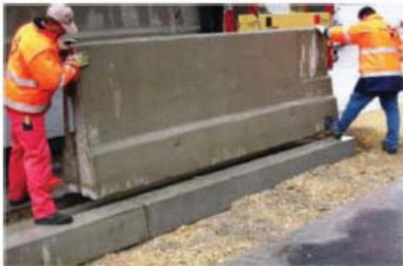
Betonschutzwand-Fertigteile der Übergangskonstruktion BC-ECO-NJ „trocken“, d.h. ohne Mörtelschicht, auf Fertigteilfundamenten montieren
