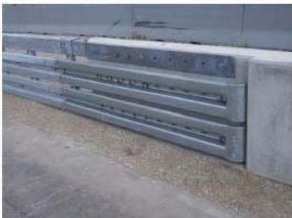
Im Betonanschlusselement wurden werkseitig Gewindehülsen einbetoniert, die ein problemloses Anschrauben der Stahlteile ermöglichen
