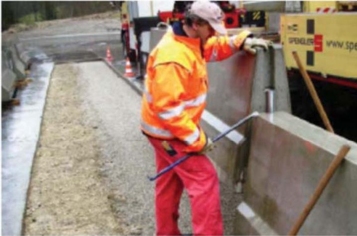
Die einzelnen BSWF werden untereinander mittels stirnseitig angeordneter Verbindungskralle verbunden
