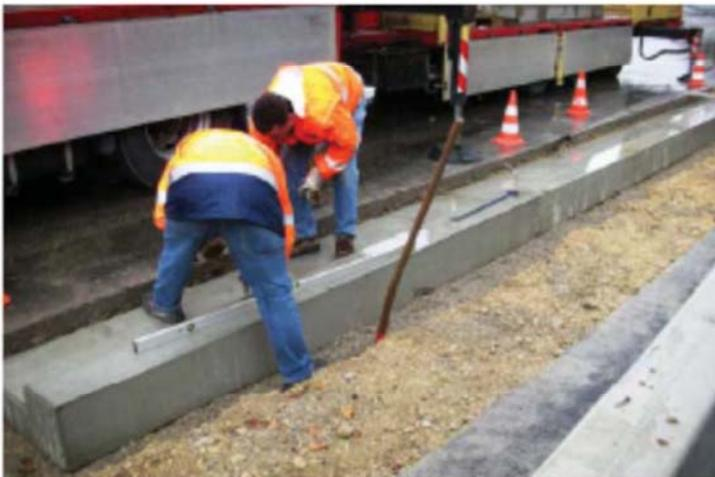
Fertigteilfundamente auf Planum setzen und ausrichten
