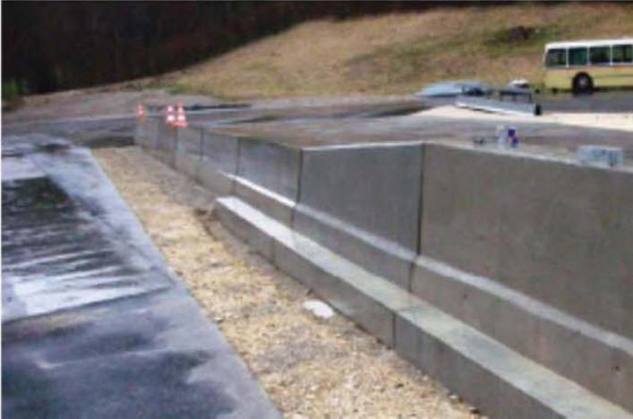
Als nächstes ist der Boden rund um die Fundamentplatten bis auf die Höhe FOK anzufüllen. (Dieser Schritt kann auch nach Montage der Stahlbauteile erfolgen)
