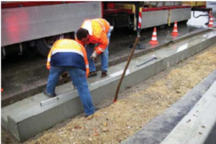
Fertigteilfundamente auf Planum setzen und ausrichten
