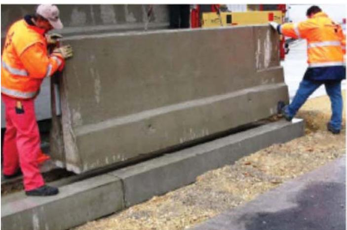
Betonschutzwand-Fertigteile der Übergangskonstruktion BC-SR „trocken“, d.h. ohne Mörtelschicht, auf Fertigteilfundamenten montieren
