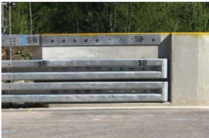
Im Betonanschlusselement wurden werkseitig Gewindehülsen einbetoniert, die ein problemloses Anschrauben der Stahlteile ermöglichen
