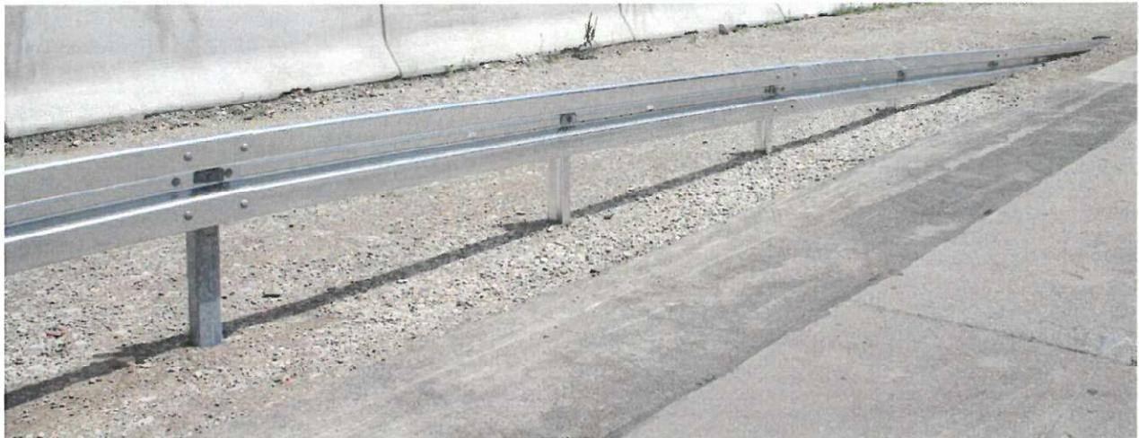
Die einseitige, gerammte Anfangs- und Endkonstruktion (AEK) besteht aus korrosionsgeschützt ausgeführten Stahlbauteilen. Die Länge der Holme und Pfosten sowie die Abmessung des Kopfstückes bestimmen die Form der Absenkung.
