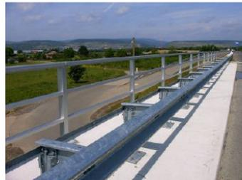
Pfosten Sigma mit Fußplatte:
