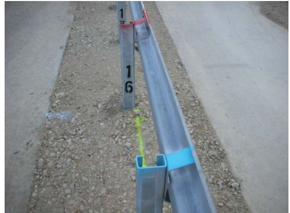
10. Fertig montierter Systemquerschnitt EASY-RAIL
