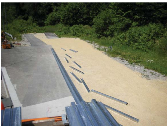
5. Auslegen der Pfosten und Stützbügel
