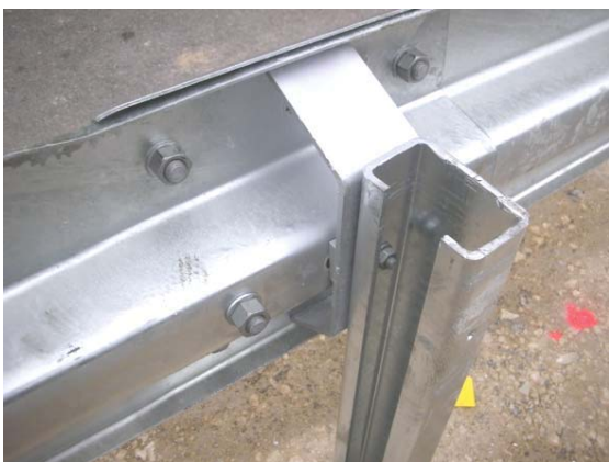
10. Detail fertige Verschraubung
