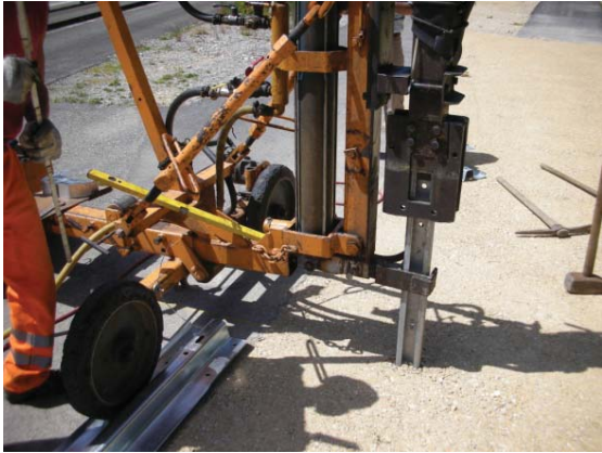
7. Rammen der Pfosten
