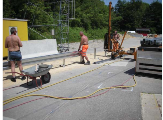
8. Vormontage Stützbügel und Holme
