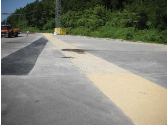
1. Arbeitsbereich vor der Montage
