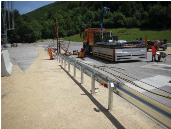
9. Montage Zug um Zug mit Rammen der Pfosten
