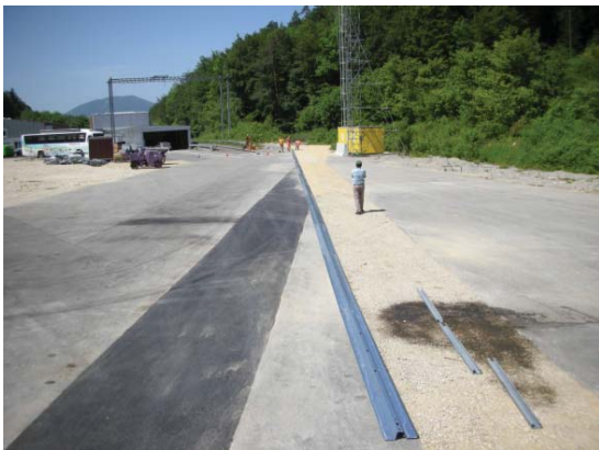
3. Ausrichten der SP Holme...
