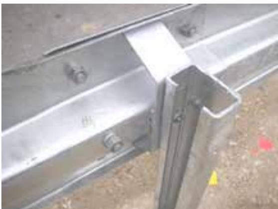
10. Detail fertige Verschraubung
