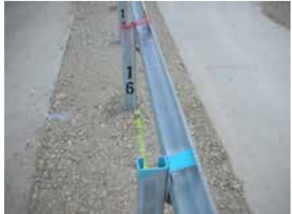
10. Fertig montierter Systemquerschnitt EASY-RAIL
