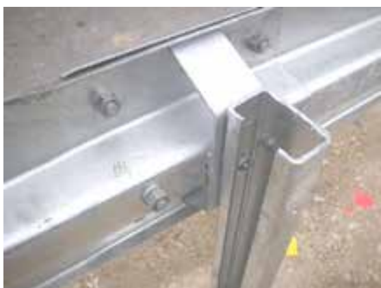
10. Detail fertige Verschraubung
