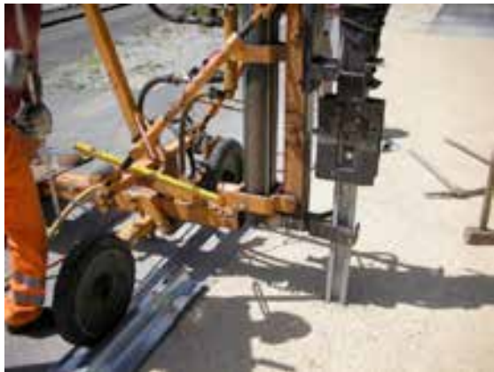
7. Rammen der Pfosten
