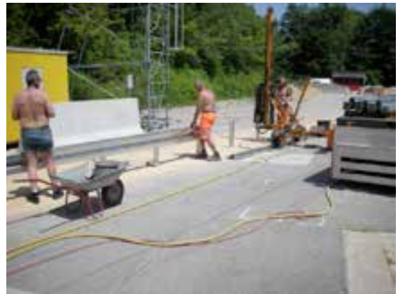
8. Vormontage Stützbügel und Holme
