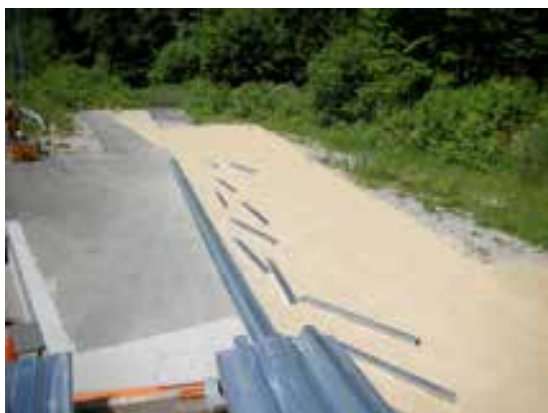
5. Auslegen der Pfosten und Stützbügel
