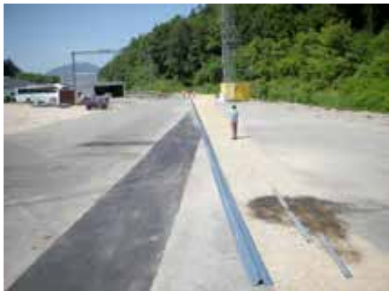
3. Ausrichten der SP Holme...
