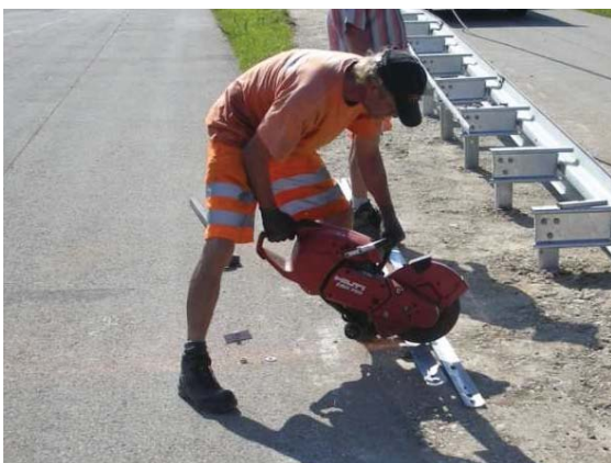
4.19 Kürzen des Abspanngurtes...
