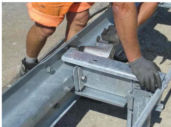
4.13 Festziehen der Schrauben...
