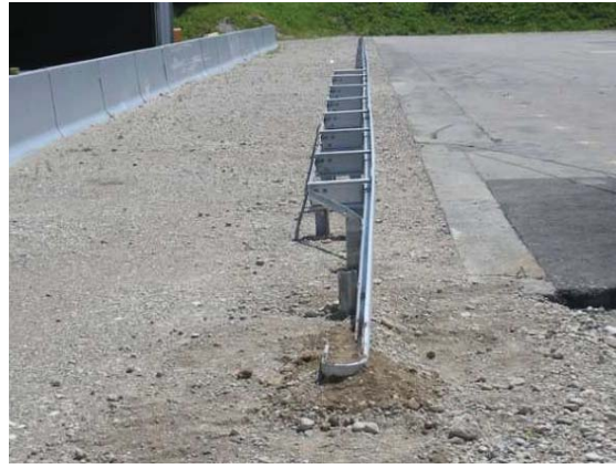
4.22 Frontalansicht der Absenkung Frontal view of the terminal
