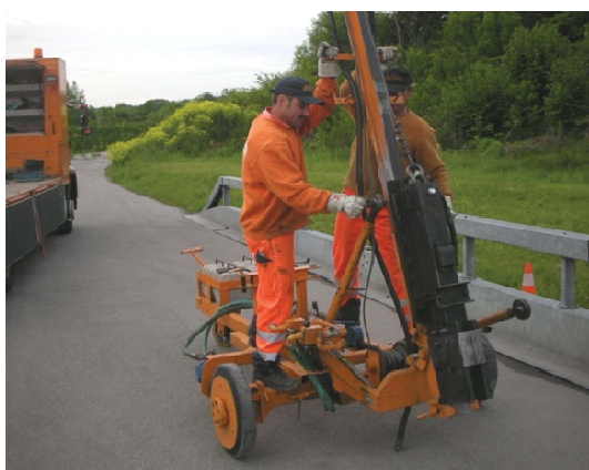
4.7 Aufbau der Ramme Preparing the pile driver
