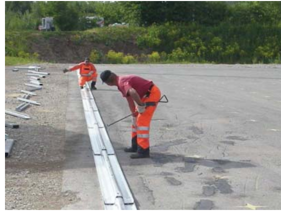
4.4 Ausrichten der Holme Aligning the beams...
