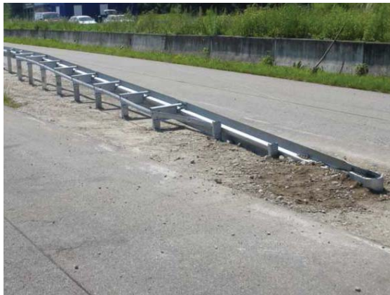
4.23 Rückseite der Absenkung Backside of the terminal
