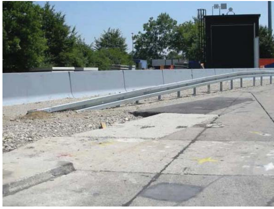
4.21 Seitenansicht der Absenkung Side View of the terminal
