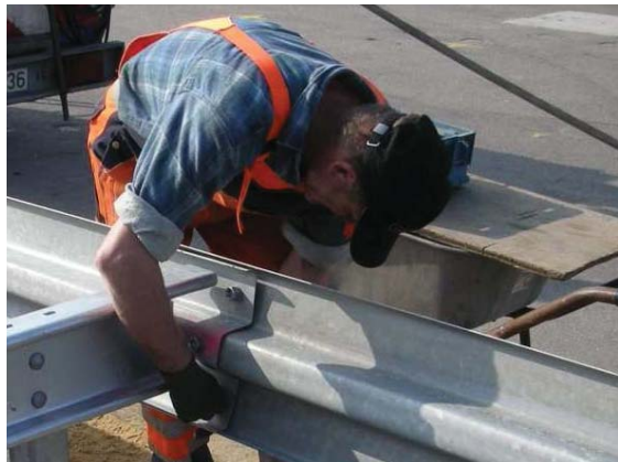
4.11 Vormontage der Verschraubung per Hand Pre-Mounting the system
