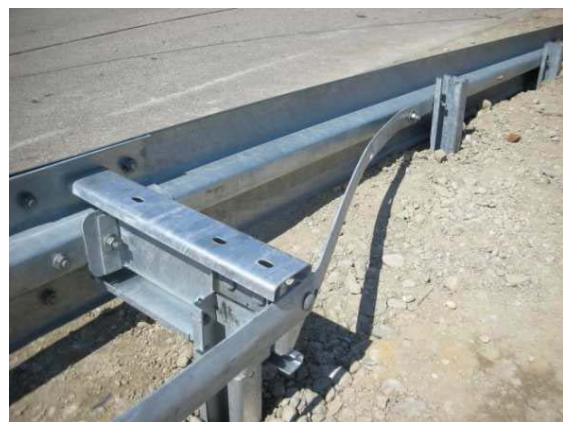
4.20 und führen des Abspanngurtes an den Holm
