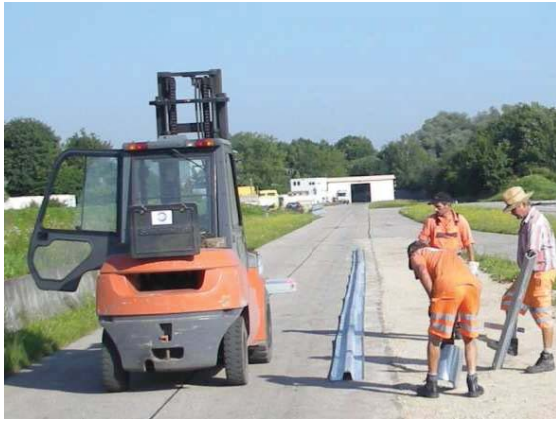
4.3 Auslegen der SP-Holme Laying the beams
