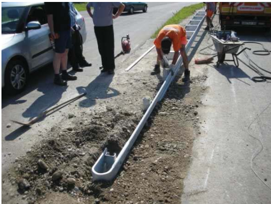
4.17 ...damit das Kopfstück und der SP-Holm eingegraben werden können
