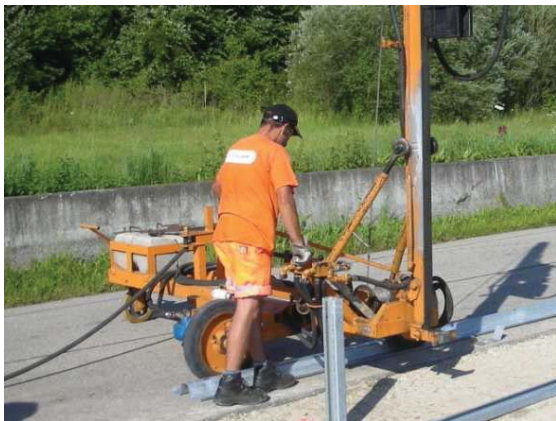
4.5 Die Holme werden später als Schiene für die Ramme benutzt ...for the piling frame
