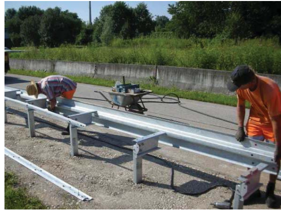
4.10 Anhängen der Bauteile Fixation of the components
