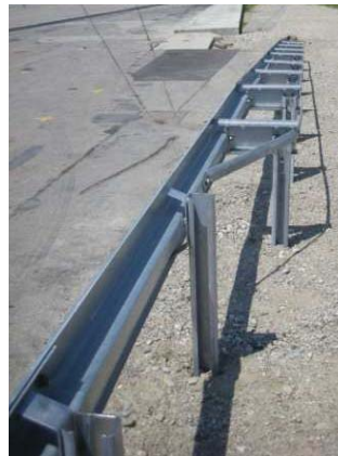
4.24 Draufsicht der Absenkung Top View of the terminal
