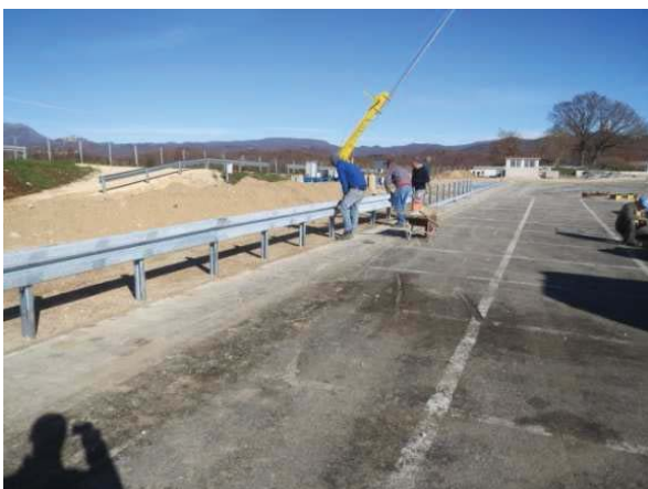
4.9 Anhängen der SP-Holme Fixation of the beams
