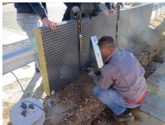
4.16 Aufstellen und Bohren der SSE mit Bohrschablone Pre-positioning and drilling of the NAE with drilling-template
