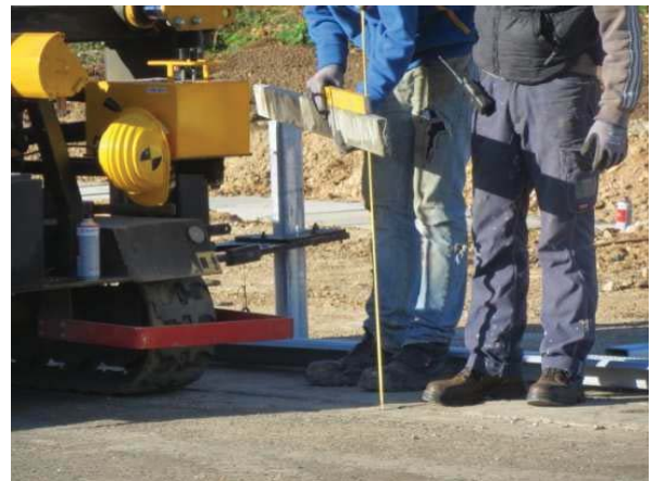
4.8 Rammen der Pfosten auf Höhe Pile driving of the posts and adjusting to the right height
