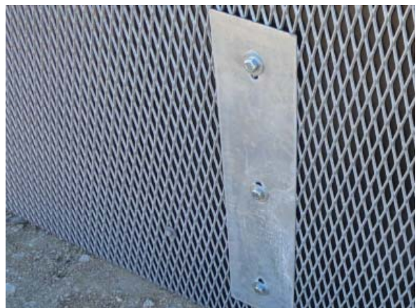
5.6 Verschraubung des SSE (Rückseite) Fixing NAE (backside)
