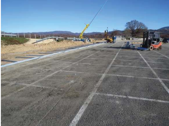
4.3 Auslegen von SP-Holmen als Schiene für Ramme Placing the beams for piling frame
