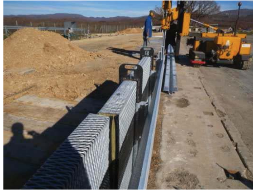
4.18 Montage erfolgt Zug um Zug mit dem Rammen der Pfosten Mounting follows step by step the piling frame
