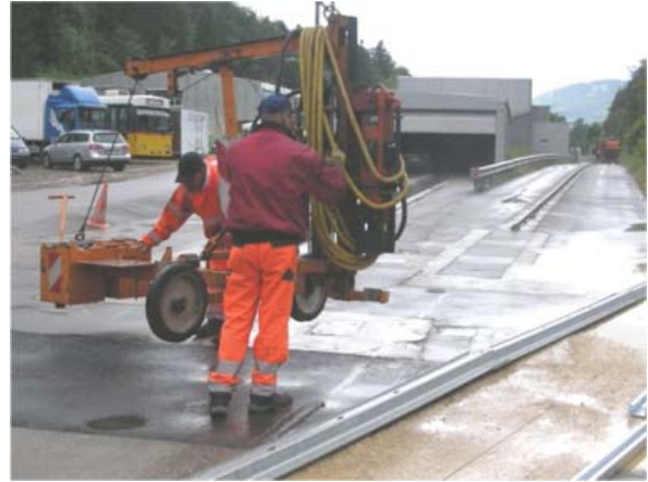
4.6 Aufbauen der Ramme Preparing the pile driver
