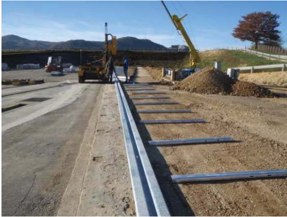
4.5 Auslegen der Pfosten Placing of the posts
