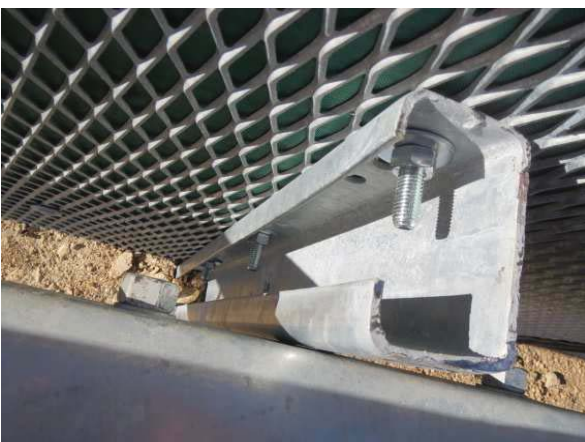
5.5 Verschraubung des SSE (Pfostenseite) Fixing NAE (post-side)
