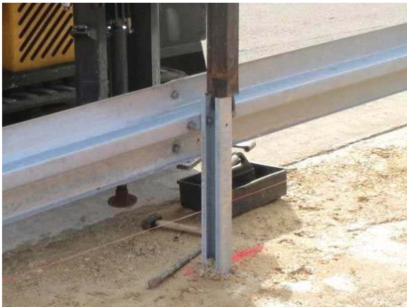
4.3 Auslegen von SP-Holmen als Schiene für Ramme Placing the beams for piling frame
