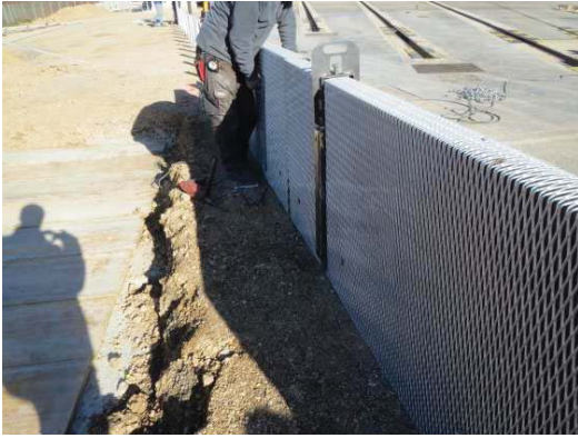
4.17 Vormontage der SSE Pre-mounting NAE
