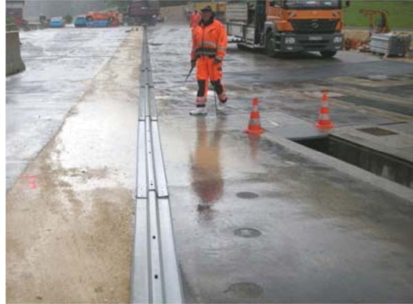
4.4 Ausrichten der SP-Holme Aligning the beams
