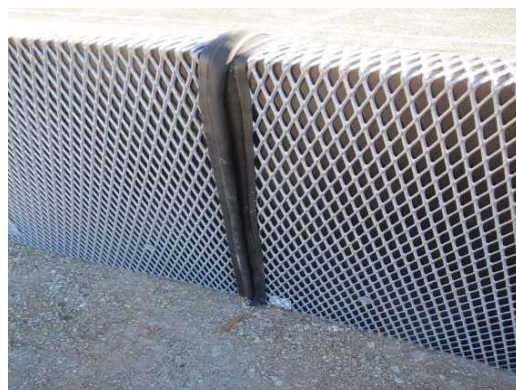
4.15 Ggf. Gummidichtung beidseitig auf Stoßkante des Streckmetallkorbs If necessary – push rubber profile on both ends of the stretched metal edge
