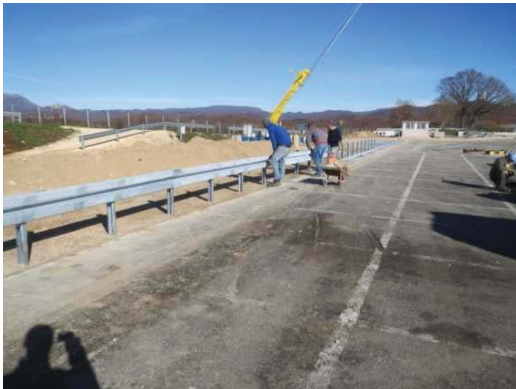
4.9 Anhängen der SP-Holme Fixation of the beams
