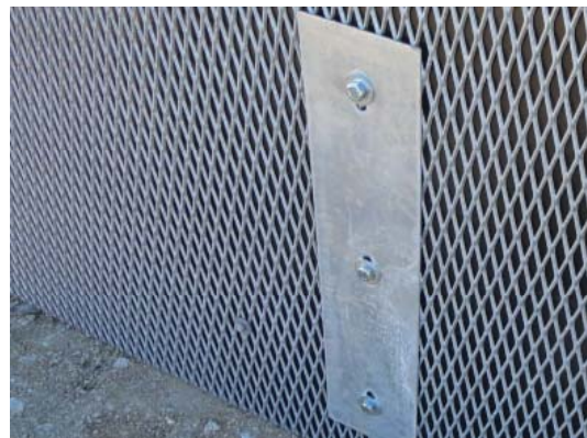
5.6 Verschraubung des SSE (Rückseite) Fixing NAE (backside)
