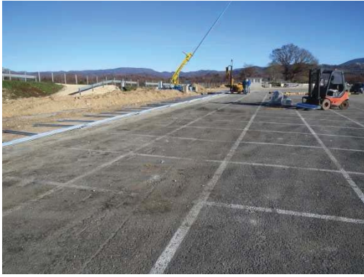
4.3 Auslegen von SP-Holmen als Schiene für Ramme Placing the beams for piling frame
