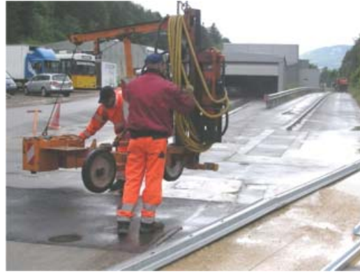
4.6 Aufbauen der Ramme Preparing the pile driver
