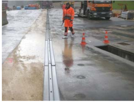
4.4 Ausrichten der SP-Holme Aligning the beams
