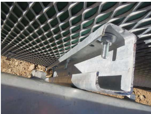
5.5 Verschraubung des SSE (Pfostenseite) Fixing NAE (post-side)
