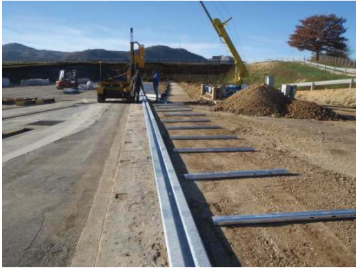
4.5 Auslegen der Pfosten Placing of the posts
