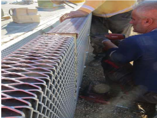
4.19 Festziehen der Schrauben... Achtung! Schallschutzelement nicht quetschen! Tightening the screws... Attention! Do not squeeze NAE !
