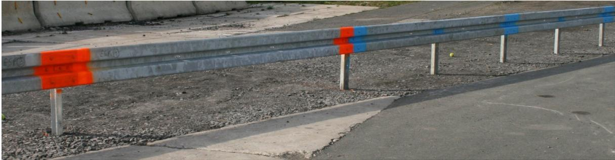
Die geramnte einseitige Übergangskonstruktion besteht aus korrosionsgeschützten Bauteilen aus Stahl nach RAL-RG 620 und verbindet die Schutzeinrichtungen ESP 4.0, N2 und Eco-Safe 2.0, N2/H1 im Stoßbereich miteinander. Die Länge der Übergangskonstruktion beträgt 0,0 m.
