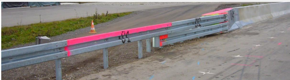
Die einseitige Übergangskonstruktion LT 1-8 – Eco-Safe 2.00 verbindet die einseitige Ortbetonschutzwand LT 205-12 mit der einseitigen Stahlschutzeinrichtung Eco-Safe 2.0 (B-Profil). Die Übergangskonstruktion besteht aus den folgenden Bereichen (von rechts nach links):
