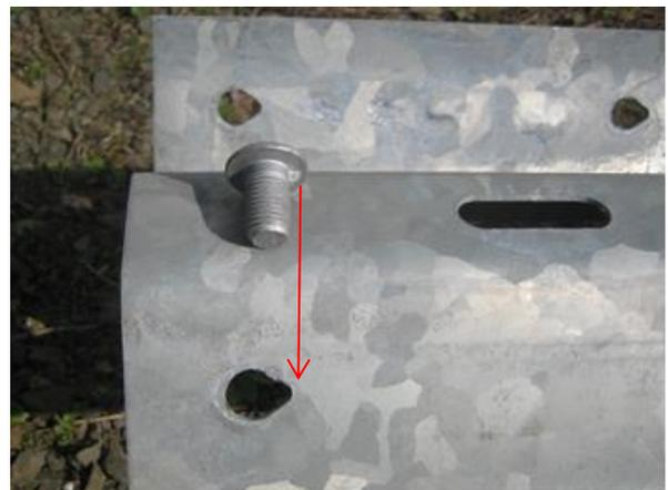
Es dürfen grundsätzlich nur feuerverzinkte Schrauben verwendet werden. Alle verwendeten Schrauben müssen über ein CE-Zeichen verfügen oder von einem zertifizierten Schraubenhersteller bezogen werden.
