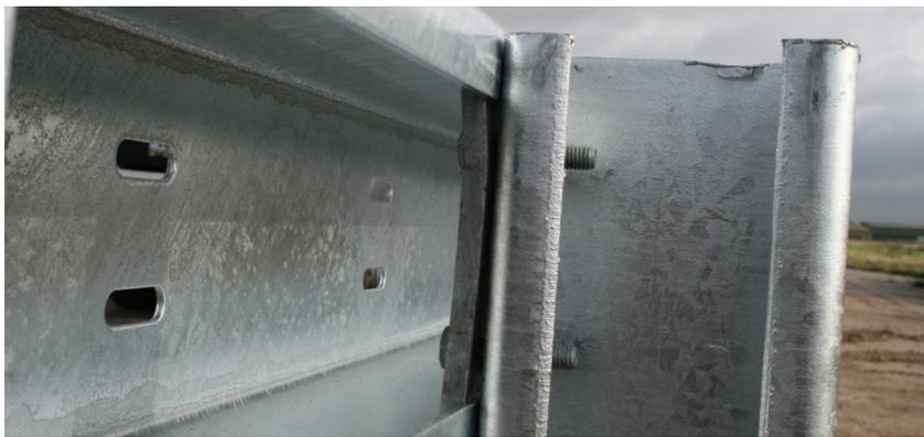
Die Kastenprofilstöße sind um 0,66 m zu den Pfosten versetzt. Insbesondere bei langgezogenen Radien kann es vorkommen, dass der Versatz zum Pfosten sich leicht verschiebt. Abweichungen von +/- 10 cm sind daher zulässig.
