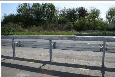
Kastenprofilstoß und Schutzplankenstoß zueinander versetzt.
