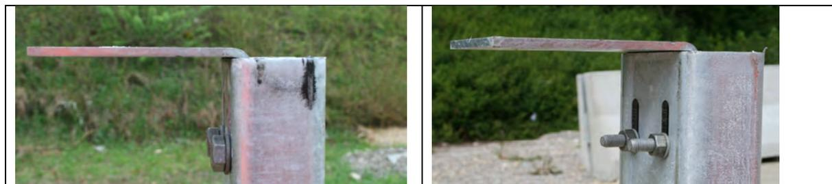
Die Deformationsbügel werden rechtwinklig zum Schutzplankenholm eingebaut werden sollen, wobei Abweichungen innerhalb des durch das Langloch im Schutzplankenholm möglichen Verschiebeweges zulässig sind. Dies entspricht einer maximal zulässigen Winkelabweichung des Defobügels von 6,5°. Gemessen werden kann die Schiefstellung wie folgt:
