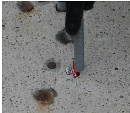
HIT-HY 200-A: Anker mit einer leichten Drehbewegung einbringen. Der Injektionsmörtel muss dabei mindestens bündig mit der Oberkante des Bohrlochs abschließen
