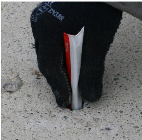
HIT-HY 200-A: Bohrloch verfüllen mit Injektionsmörtel (ca. 9-10 Hübe).
