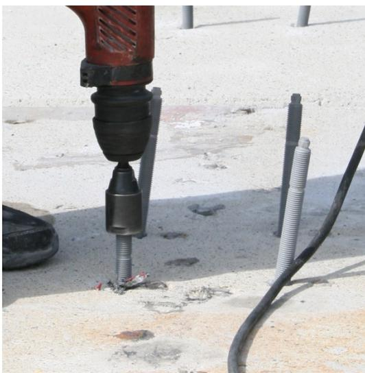
Anker mit einem elektro-pneumatischen Bohrhämmer oder einer Schlagbohrmaschine mit Hammer-/Schlag-Bohren (axialer Schlag + Drehbewegung) eindrehen. Ein Schlagschrauber ist nicht geeignet, da dieser einen drehende Schlagfunktion (tangential) hat.
