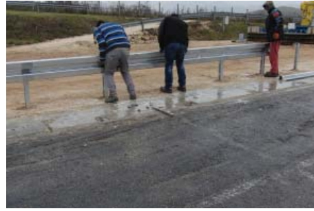
4.6 Anhängen der SP-Holme Fixation of the beams
