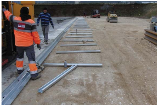
4.3 Auslegen der SP-Holme und Pfosten Aligning the beams and placing the posts
