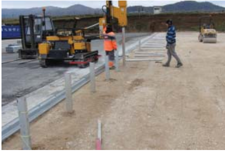
4.5 Rammen der Pfosten Piling in posts
