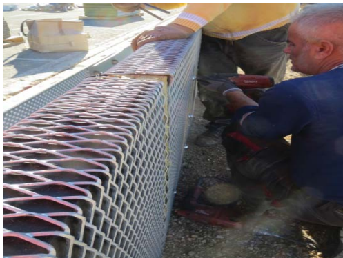
4.12 Benötigter Bohrer Ø 14 mm Needed drill Ø 14 mm
