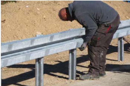
4.7 Vormontage der Verschraubung per Hand Manually prefixing of bolts
