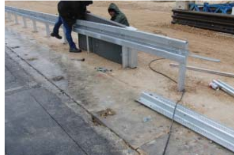
4.8 Montage des ersten Schallschutzelements für Übergang (ÜK-SSE) Mounting of the first noise absorbing element for transition (Trans-NAE)
