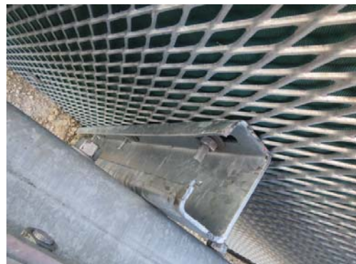
4.23 Verschraubung des SSE (Pfostenseite) Fixation NAE (post-side)
