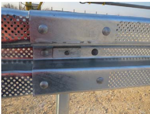
4.22 Verschraubung vorne am SP-Stoß Front-side – Fixing at beam joint
