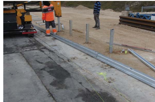
4.4 Spannen der Schnur als Streckenführung für die Ramme Optical line as guidance for the pile-driver
