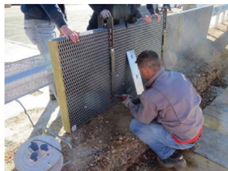
4.11 Aufstellen und Bohren des SSE mit Bohrschablone Pre-positioning and drilling of the NAE with drilling template
