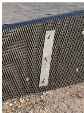
4.24 Verschraubung des SSE (Rückseite) Fixing NAE (backside)
