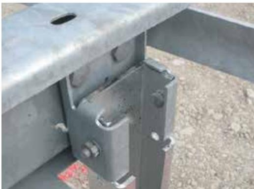
4.25 Verschraubung Klaue mit ausgeklinktem C-Pfosten
