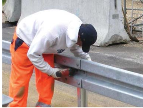
4.17 Festziehen der Schrauben... Tightening of the screws...
