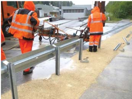
4.12 Montage erfolgt Zug um Zug mit dem Rammen der Pfosten Mounting follows step by step the piling frame
