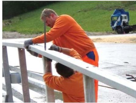
4.11 Vormontage der Verschraubung Pre-Mounting of the system
