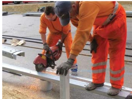
4.13 Ablängen des Handlaufes... Cutting-off handrail...
