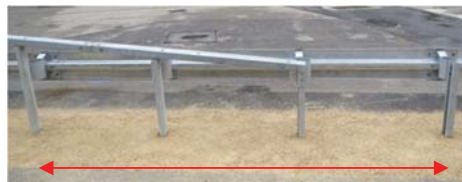
6.4 Feld 2 – Ende Handlauf Section 2 – End of Handrail
