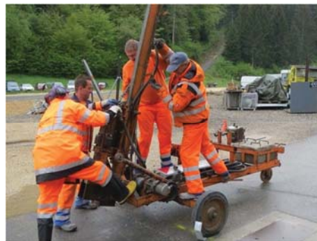
4.7 Aufbauen der Ramme Preparation of the pile driver
