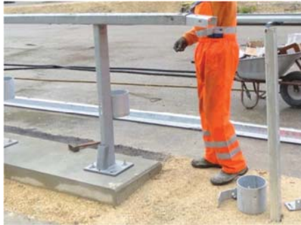
5.4 Detail – Verbindungsstelle ER 1.33 BW und Übergang Detail – Connection point ER 1.33 OS to transition
