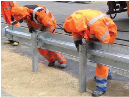
4.10 Anhängen der Bauteile Fixation of the components
