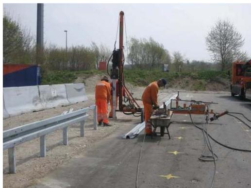
4.10 Montage erfolgt Zug um Zug mit dem Rammen der Pfosten
