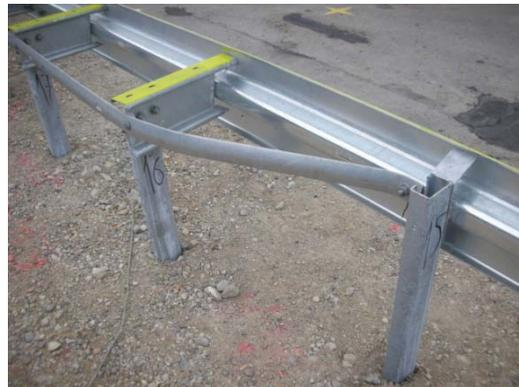
4.22 Detail - Anschluss Abspanngurt
