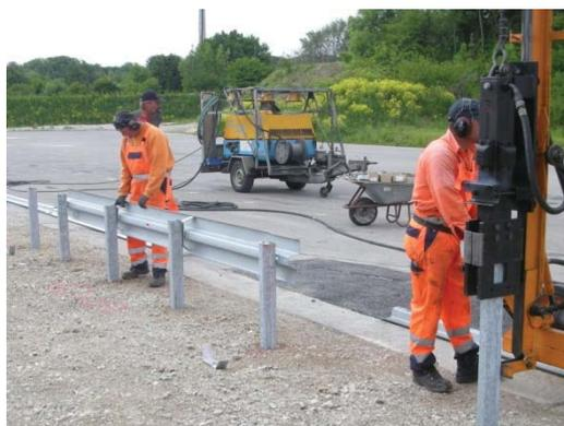
4.12 Montage erfolgt Zug um Zug mit dem Rammen der Pfosten
